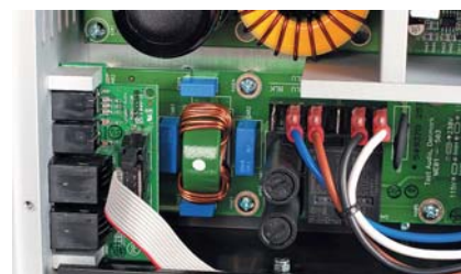
Lyngdorf chwali się filtrowaniem napięcia zasilającego, zanim jeszcze trafi ono do głównego transformatora.
