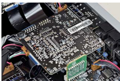
Moduł komunikacji sieciowej przesyła sygnał do dekodowników audio oraz procesorów wizyjnych.
