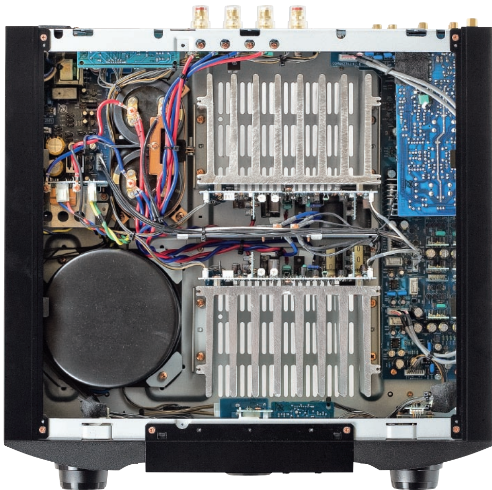
Nietypowa aranżacja układów wiąże się z zaprojektowaniem krótkiej ścieżki sygnału.
