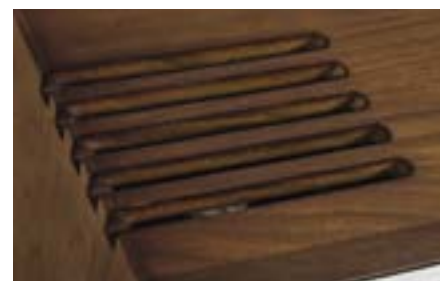
Wycięcia w drewnianej osłonie służą wentylacji lamp.
