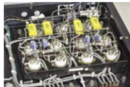
Montaż punkt-punkt - pracochłonny i wymagający staranności, ale w dobrym wykonaniu wcale nie gorszy niż na eleganckiej płytce.
