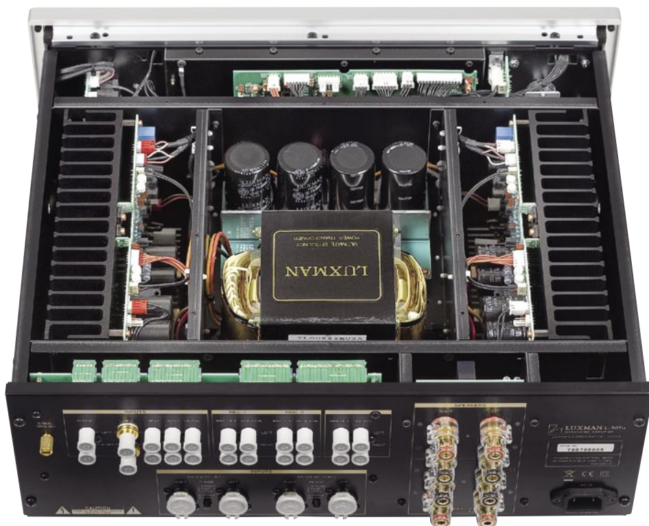
Konstrukcję podzielono na sekcje oddzielone ekranami. Na środku króluje duży transformator z klasycznymi blachami EI.
