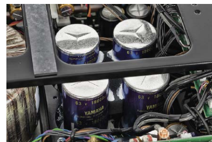
W zasilaczu obok sporego transformatora toroidalnego przygotowano dużą pojemność filtrującą (łącznie 72 000 \mu F).
