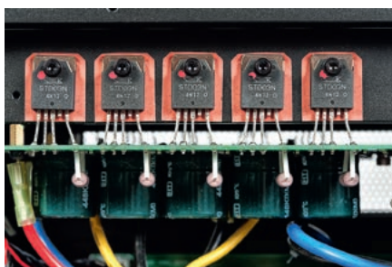
Tranzystory wyjściowe przykręcono do kształtowników, a następnie do radiatorów; w sumie w każdym kanale pracuje aż dziesięć tranzystorów.
